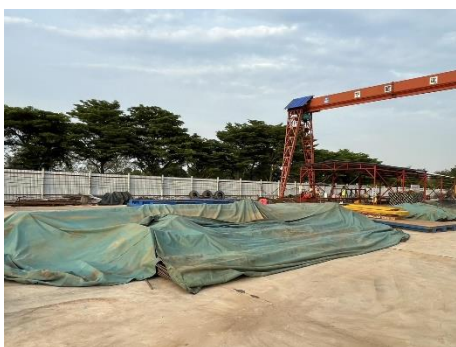
ภาพที่ 2.2-10 การปิดคลุมวัสดุก่อสร้าง
